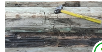
Entfernen von Nägeln, Schrauben und anderen Verbindungselementen
