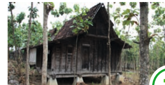
Abriß des Holzhauses
